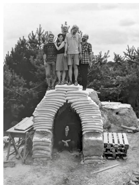
Jany: „Budownictwo ekologiczne, wykańczanie konstrukcji i test wytrzymałości”.
